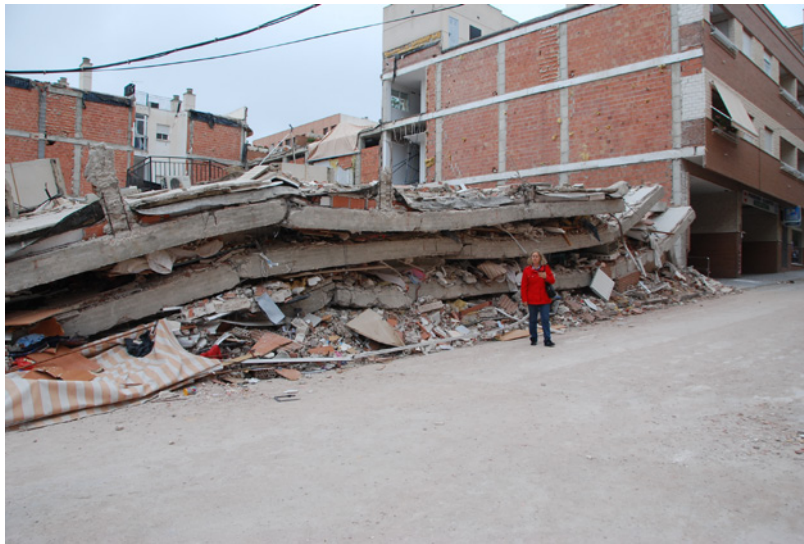
Figura 38: Edificio colapsado en el barrio de La Viña (Lorca). Imagen cedida por: E. García Cruz (2011).
