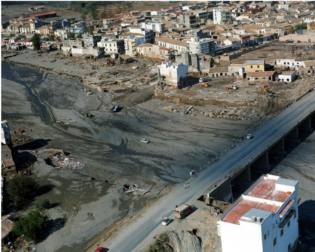
Figura 18: Rambla de Nogalte a su paso por Puerto Lumbreras después de la avenida de octubre de 1973. Fuente: Paisajes españoles.
