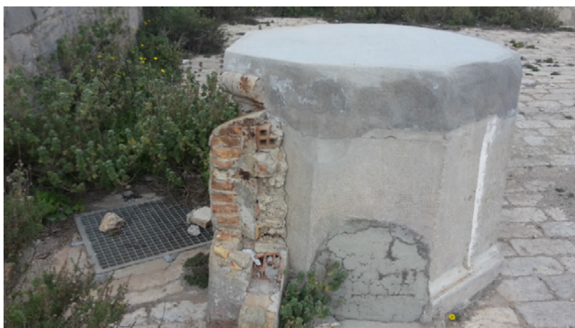
Figura 7. Pozo situado en el ángulo NW. Fuente: fotografía propia (2016).
