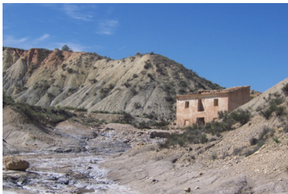
Figura 7. Casa del salinero en las Salinas del Curro y Rambla de las Tejeras. Autor: Marcelo Bravo, 2015.
