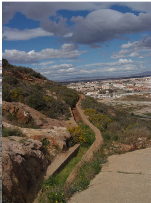
Figuras 10 y 11. Boqueras situadas en la falda de la montaña y depósito (izq.) y detalle de boquera o canal que discurre por la falda de la montaña, en las inmediaciones de la fortaleza (dcha.). Se observa la inclinación de la pendiente para dirigir el agua hasta el depósito más cercano. Fuente: fotografía propia (2016).
