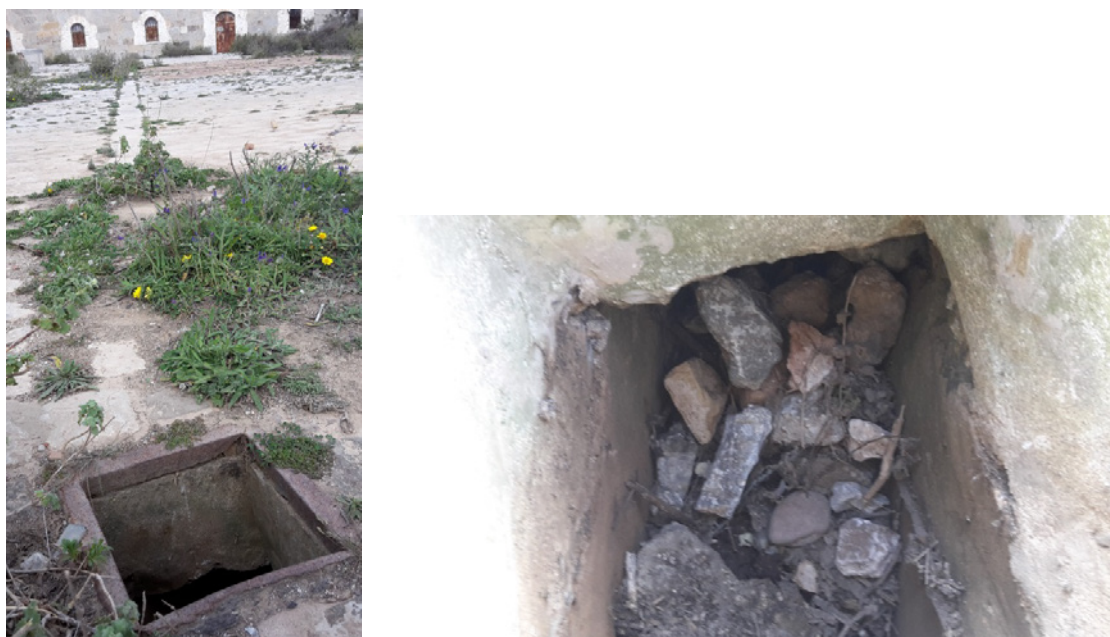
Figuras 4 y 5. Detalle de la galería subterránea del patio central, tomada desde la arqueta de confluencia y con dirección a la cisterna NW. Fuente: fotografía propia (2016).
