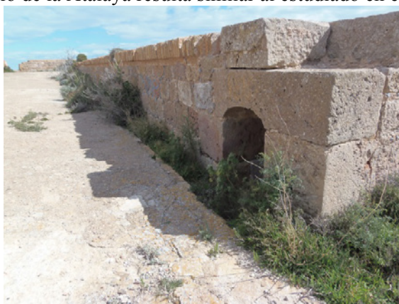
Figura 8. Sistema de recogida de aguas en el nivel superior del Castillo de la Atalaya. Fuente: fotografía propia (2016).
