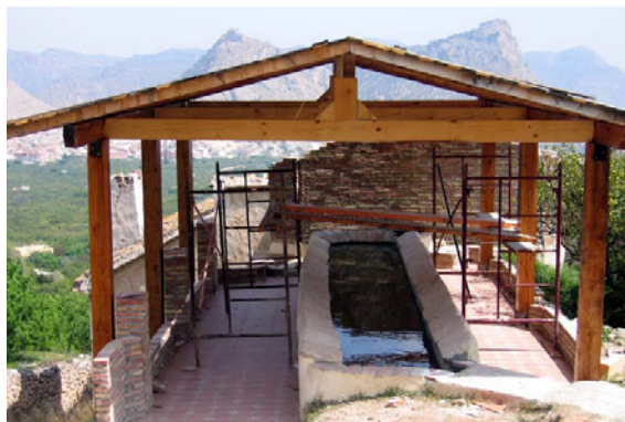
Figura 4. Restauración del Lavadero Público de “Los Molinos”, en Ricote. Autor: Ayuntamiento de Ricote. 2003.
