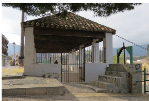
Figura 3. Lavadero Público de Escanales, que corresponde al tipo de lavadero techado, Blanca. Autor: Marcelo Bravo. 2016.
