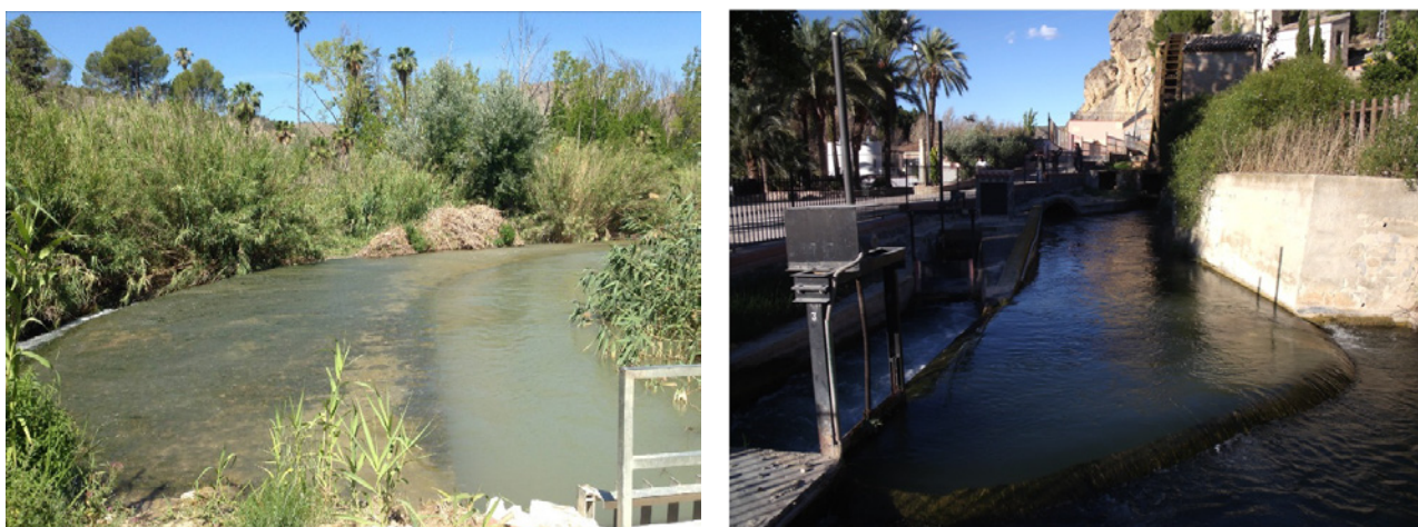
Figura 1. A) Izquierda: Presa del Menjú (Cieza) B) Derecha: Partidor de las acequias Principal de Abarán y Principal de Blanca en el paraje de las Canales (Abarán). Al fondo la Noria Grande de Abarán o del Molino de Papel. Fuente: Molina, J. (10-6-2016); Gómez, J.M a . (27-10-2012).
