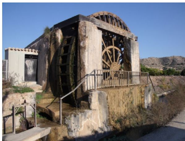
Figura 5. Noria de la Hoya de D. García. Rueda de corriente baja en el tramo conjunto de las acequias Principal de Abarán y Principal de Blanca. Fuente: Gómez, J.M a . (13-11-2015).
