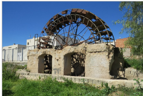
Figura 4. Noria de Chirrinches (Archena), construida en su totalidad en hierro. Autor: Marcelo Bravo, 2016.
