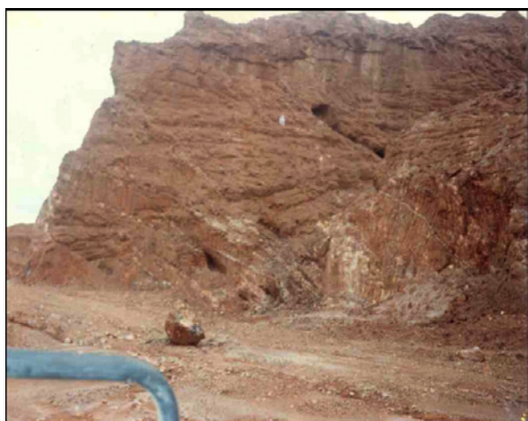
Figura 3 - Desmonte Mecânico - Serra de B. Futuro Autora M. M. Ferreira, 1995
