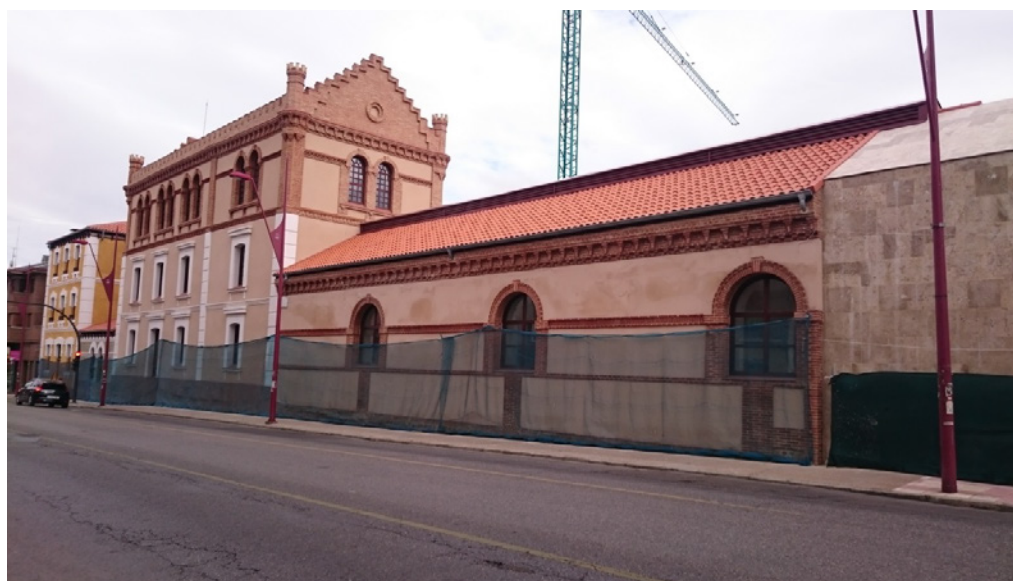
Figura 3. Aspecto actual de la fábrica Araú (Trojajo del Camino-León) tras las obras de rehabilitación. Fuente: Imagen tomada por Lidia García (2015).
