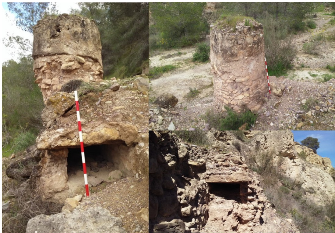
Figura 4. Séptima lumbrera asociada al sistema de excavación en galería “La Pizorra”. Fuente: Autor, fotografías tomadas 07/03/2015.
