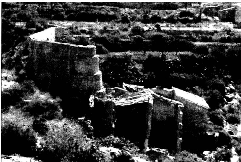
Figura 5. Molino Alto en Aledo. Las ruedas son movidas por el agua captada mediante galerías de fuentes y manantiales de Sierra Espuña.
