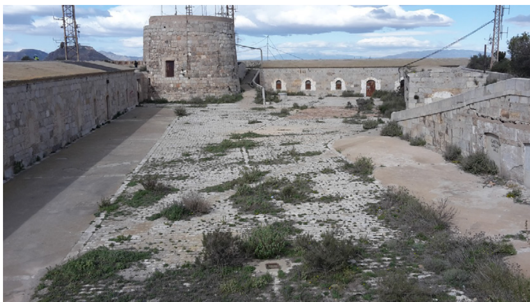
Figura 3. Vista del patio central del Castillo de San Julián, donde se pueden observar el trazado de las galerías, arquetas de confluencia, y al fondo, pozos y brocales. Fuente: fotografía propia (2016).
