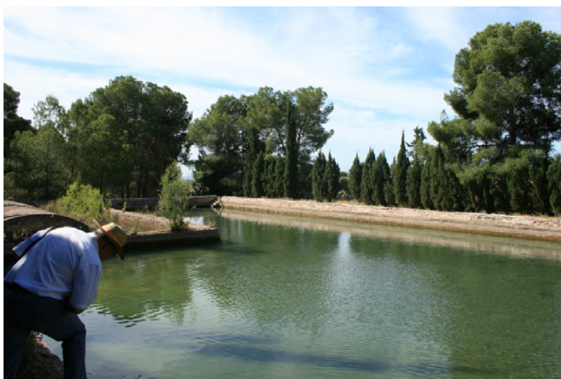
Figura 4. Primer Estanque de acumulación de las aguas captadas por la galería del Azaraque.
