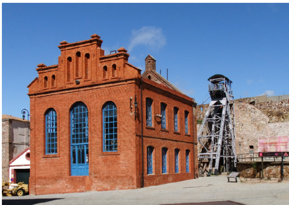
Figura 1. Pozo San Aquilino en el Parque Minero de Almadén. Fuente: M.C. Cañizares (2016).
