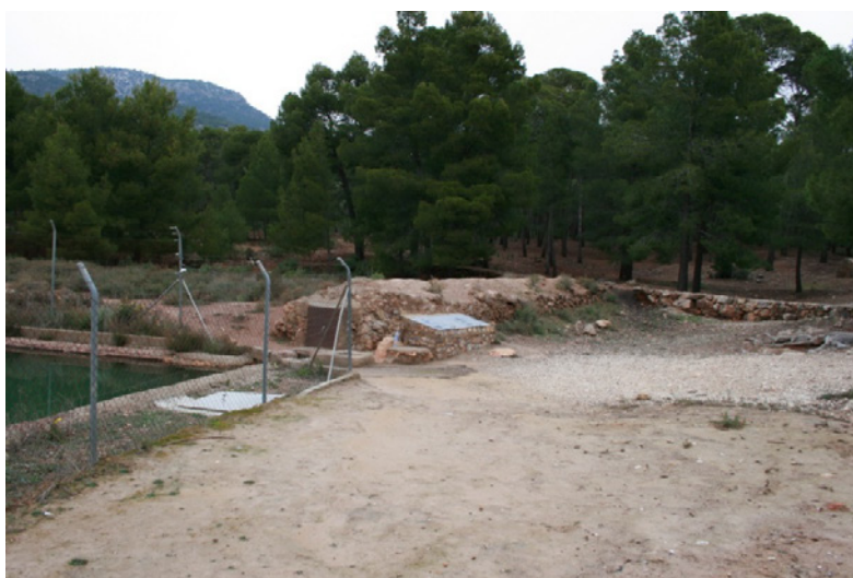
Figura 3. Bocamina del qanat de Las Alquerías, justo al pie de una de las balsas de acumulación de agua de este sistema.
