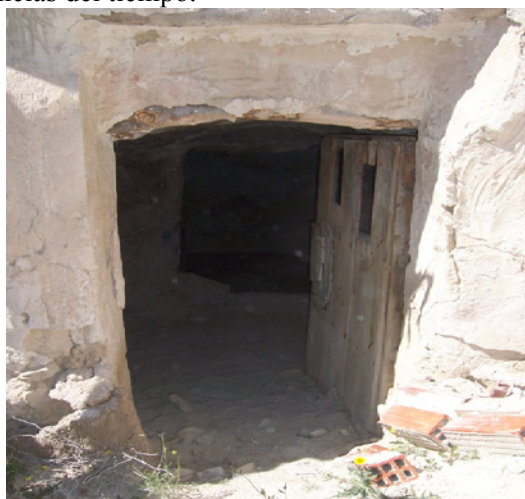
Figura 6: Acceso a la casa del salero en las Salinas de San Antonio. Autor: Pastor, M. 2015.
