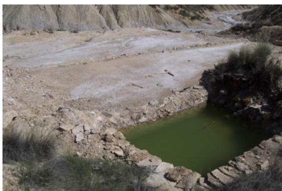
Figura 8: Balsa que recogía las aguas de un pequeño venero y varias eras para la producción de sal: Autor: Marcelo Bravo, 2015.
